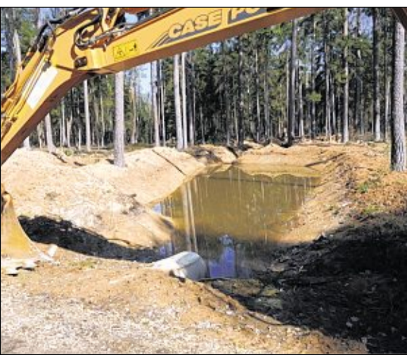
Quasi als Nebenprodukt des Straßenbaus entstand dieser kleine Teich für Regenwasser neben der Kreuzung an der Unterstellhütte.
