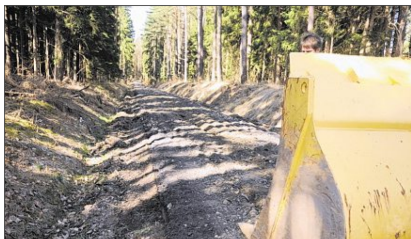
Neu aufgebaut wird die Straße nach Frankenhof derzeit: Noch regieren hier die Baumaschinen, bald kommt eine neue Decke drauf.
